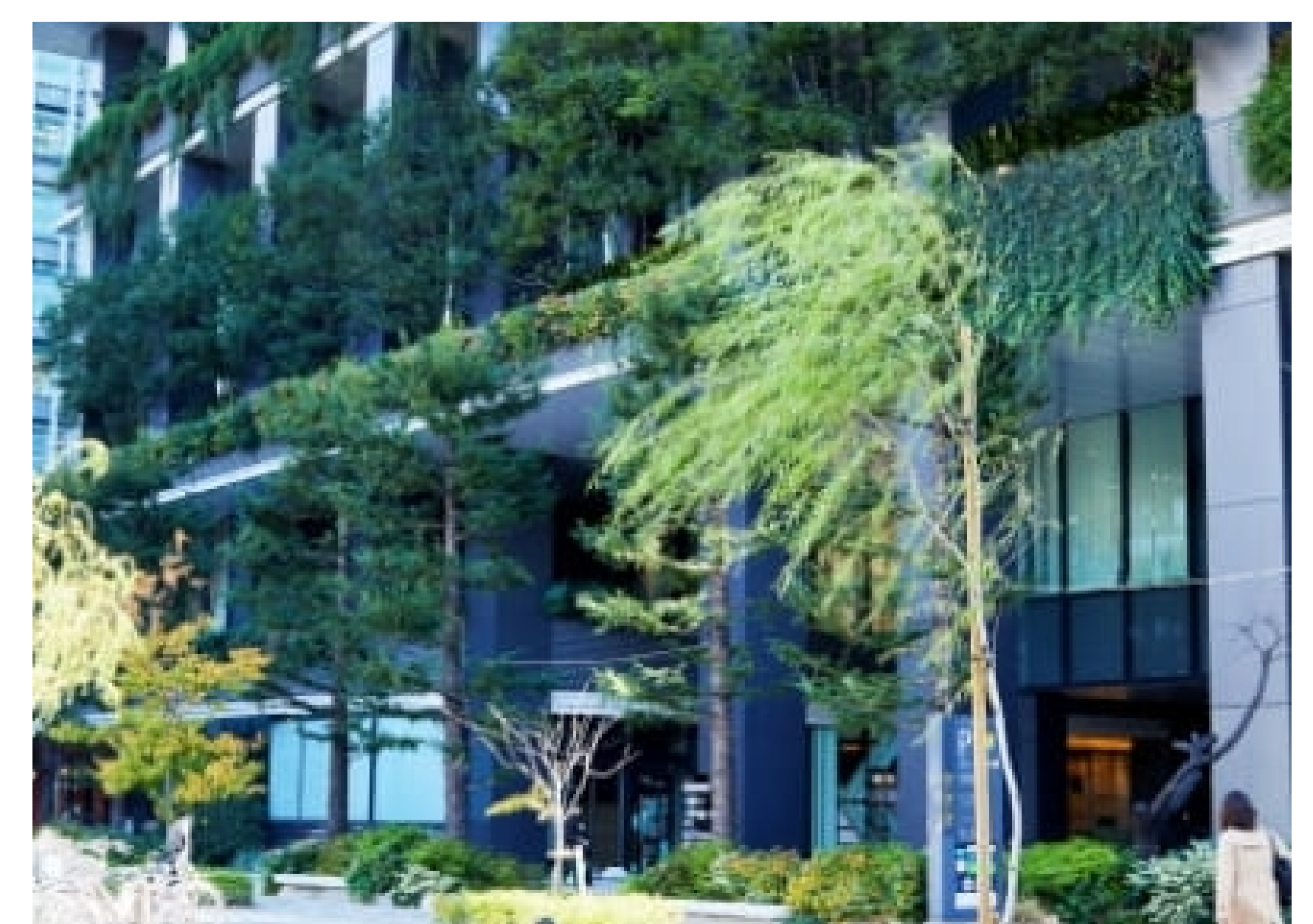
「小松ビル」から出てすぐの駅に向かう入口
