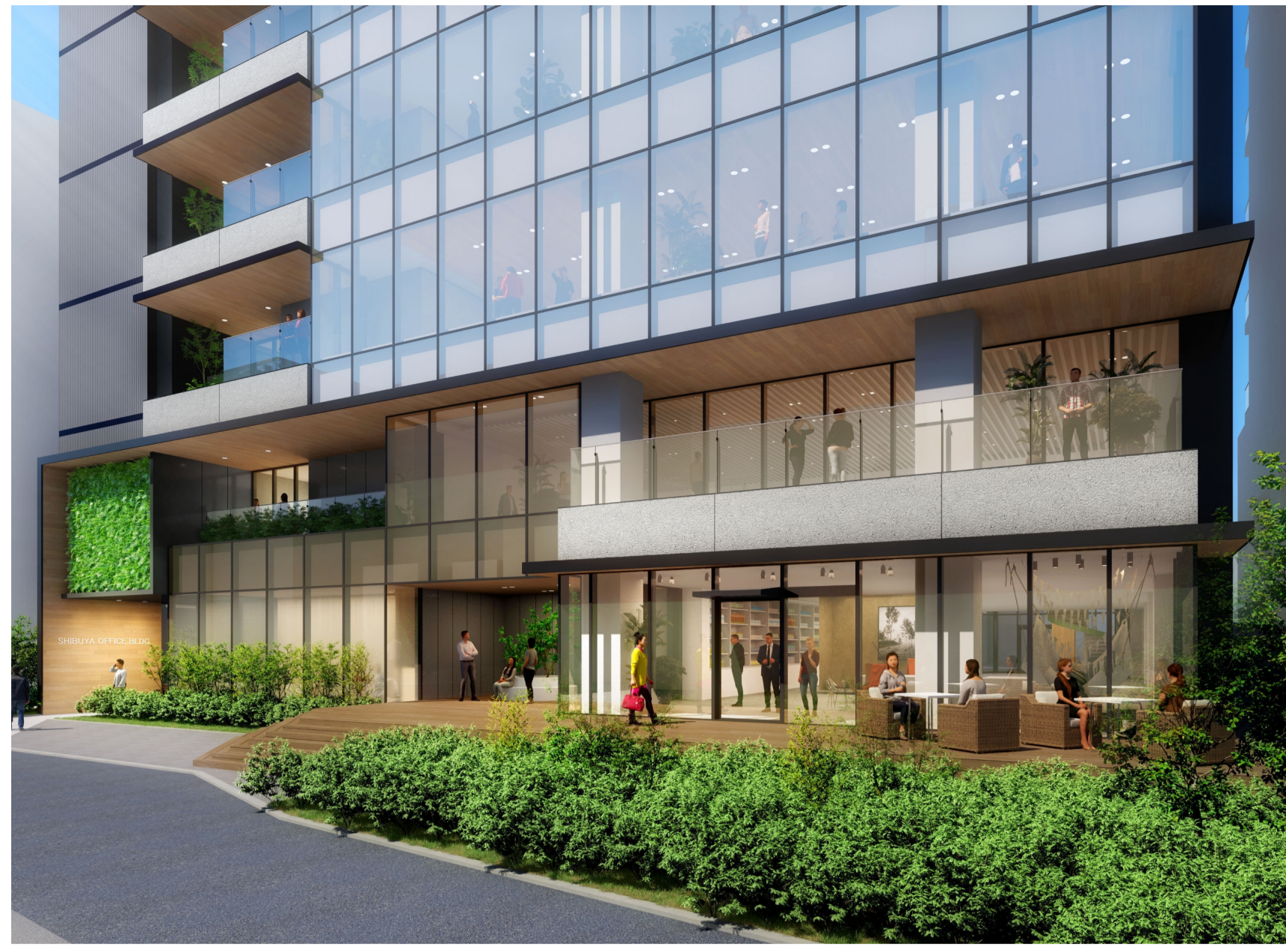
入り口は渋谷駅側と渋谷川側の2箇所。こちらは後者のエントランス。
