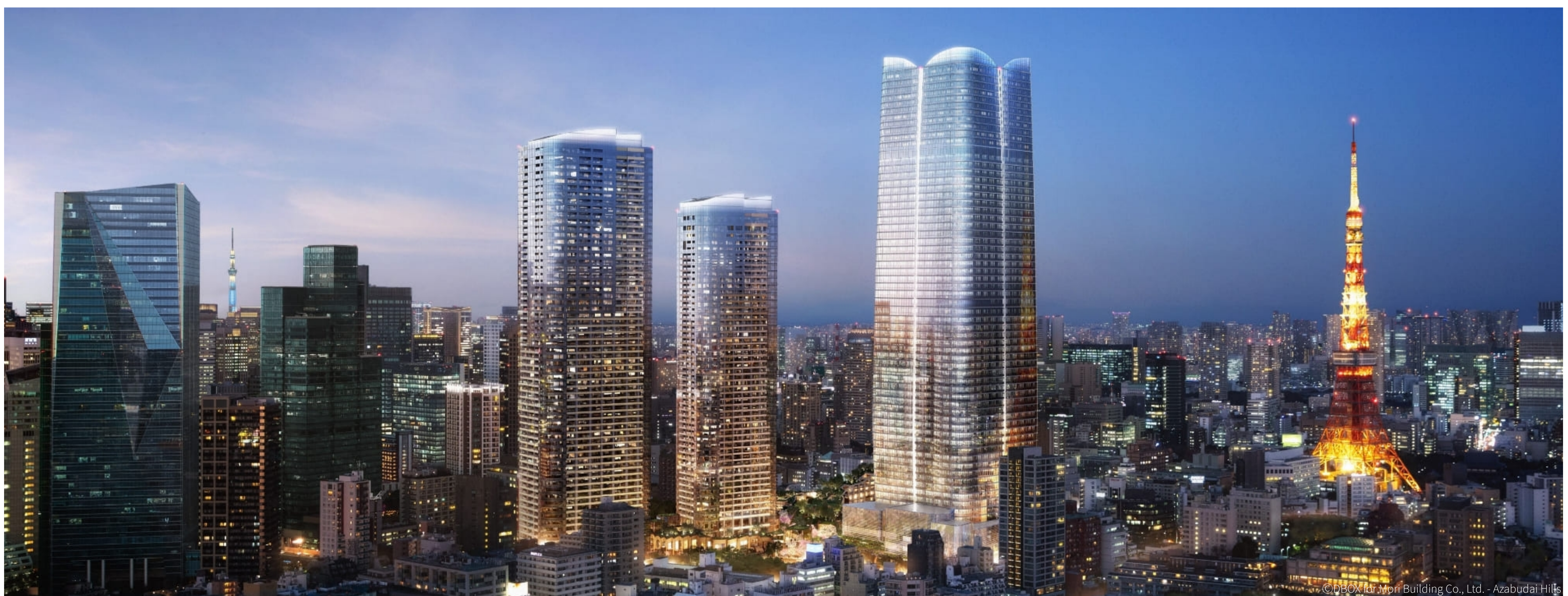
麻布台ヒルズの全景。中央右が「森JPタワー」
