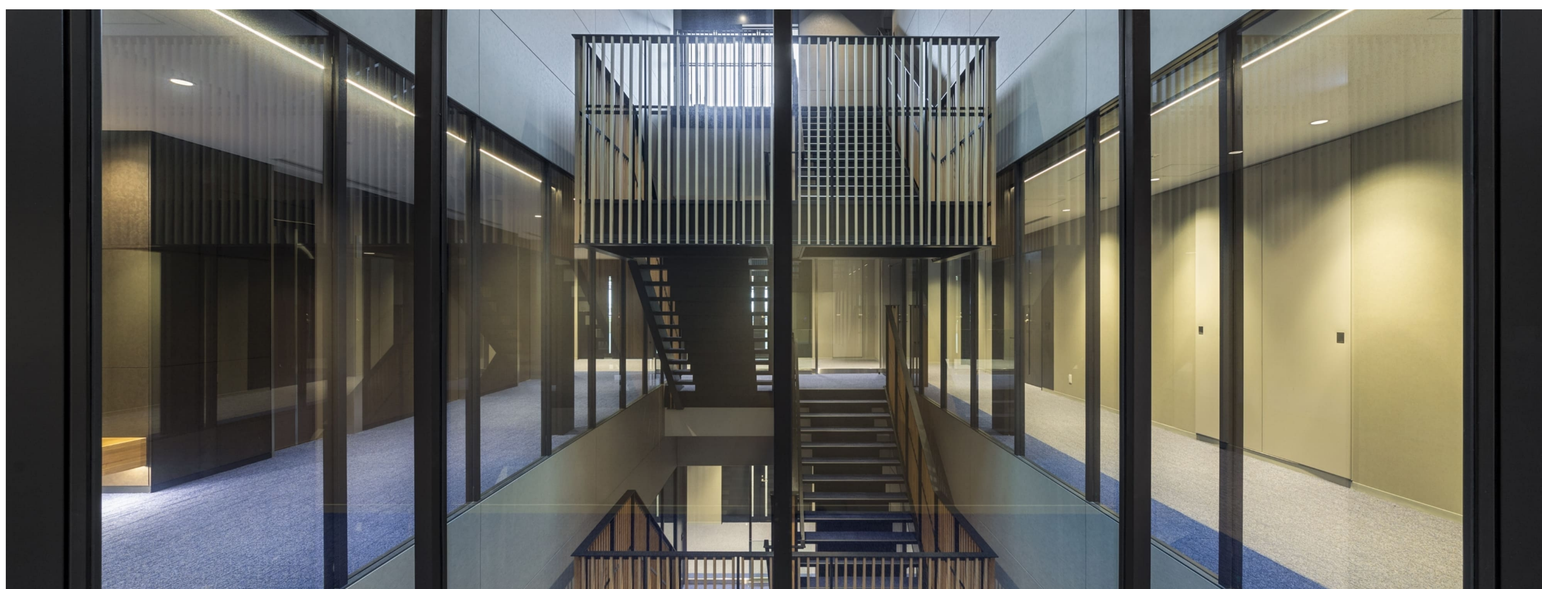
広大なフロアプレートの中央部分の明るさを確保するために、4層吹き抜けの内部階段を設置。
